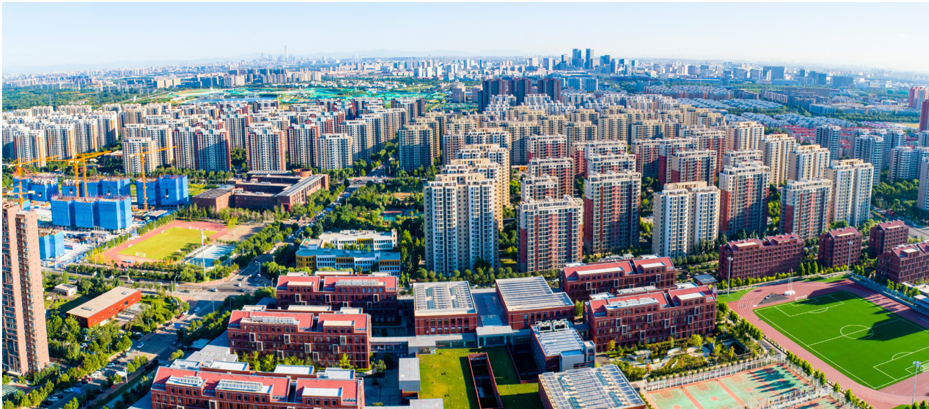
“十二平方公里”安置房项目
