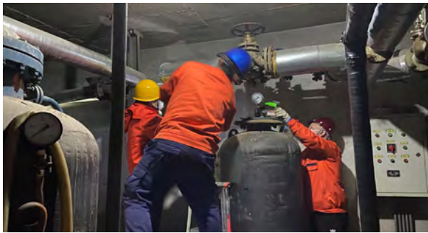
疫情防控期间，开拓热力300多名一线员工，始终坚持每天按时到岗上班，做好供热保障
