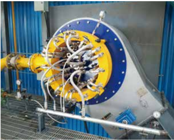
燃烧器改造后
