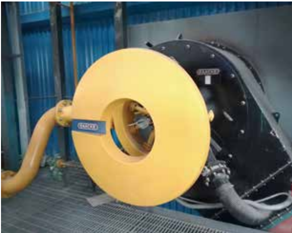
燃烧器改造前
