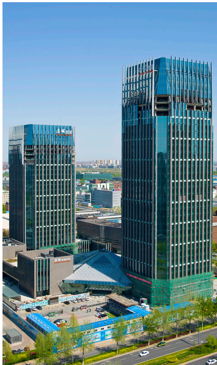
亦城财富中心（第一个“美丽工地”项目）
